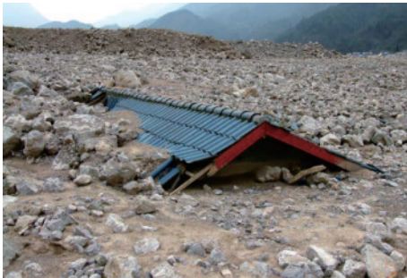
(a) 沟口处被整体淤埋的建筑(来源: blog.sina.com.cn)
