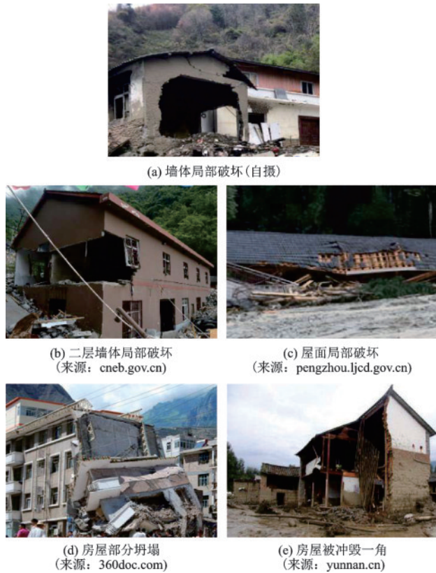
图3 建筑物的局部破坏形态
