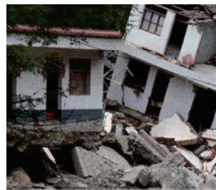
(a) 地基部分被掏空(来源: gs.cnr.cn)
