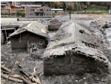
(c) 沟口处被泥石流掩埋的建筑(自摄)
